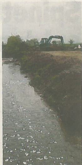
Lavori lungo il Lovassina
